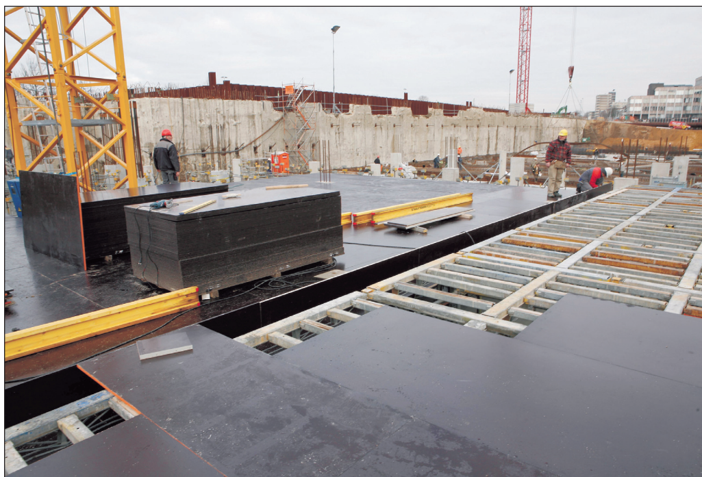
Afbeelding 2. Toepassing betontriplex.
