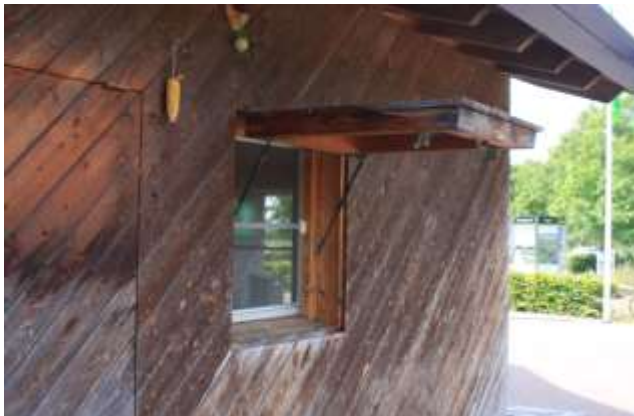
Afbeelding 16. Dakoverstekken en andere uitkragingen zorgen voor aftekening bij vergrijzen.
