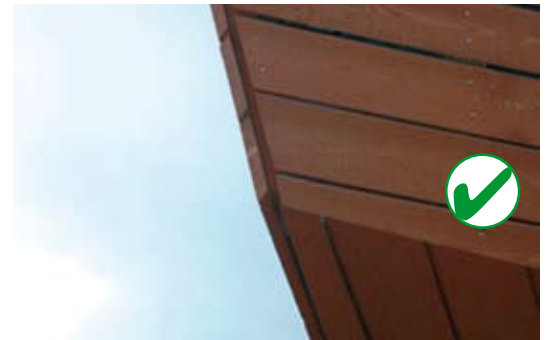
3 lagen kleurbeits op fijnbezaagd oppervlak.
